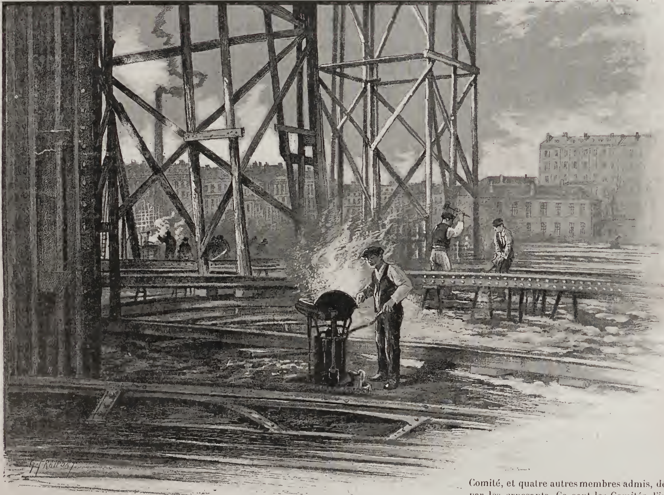
AUX INVALIDES. — Forge mobile pour le chauffage des rivets.
